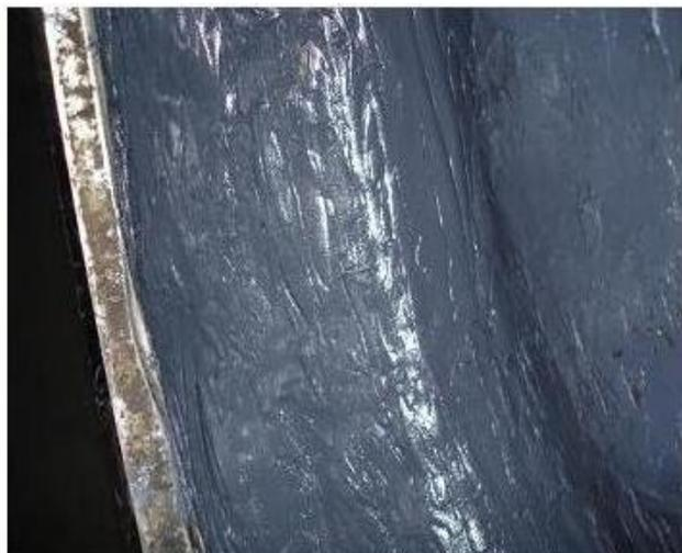
4. Нанесение двухкомпонентного полимерного материала с вкраплением (керамической крошки, карбида кремния, мрамора и гранита) Эмаль «SHEG®-774PU» для защиты от абразивного износа.
